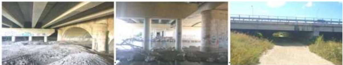
Ilustración 13. Fotografías tomadas bajo el paso de la primitiva N340a (actual MA-21), y aguas arriba, en visitas realizadas por este consultor, apreciándose que la sección más desfavorable se corresponde con el puente primitivo.
