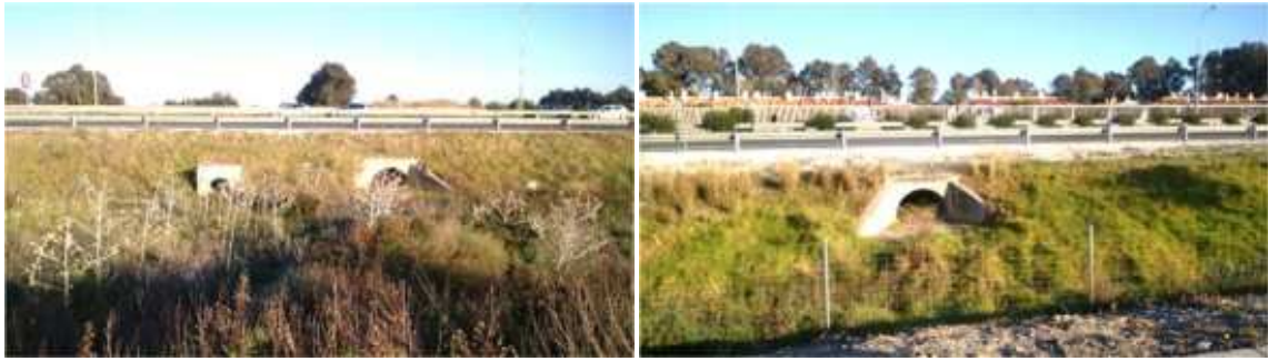
Ilustración 17. Canal abierto y embovedado de desagüe del margen noreste de la MA-20.
