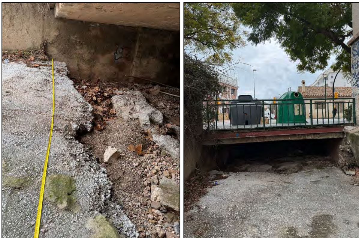
Ilustración 21. Imagen de la visita a la zona donde se encuentra la obra de drenaje.
