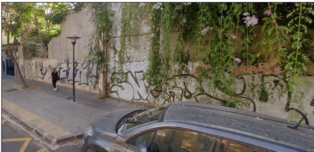
Vistas de Google Maps donde se aprecia el estado de abandono del ámbito
