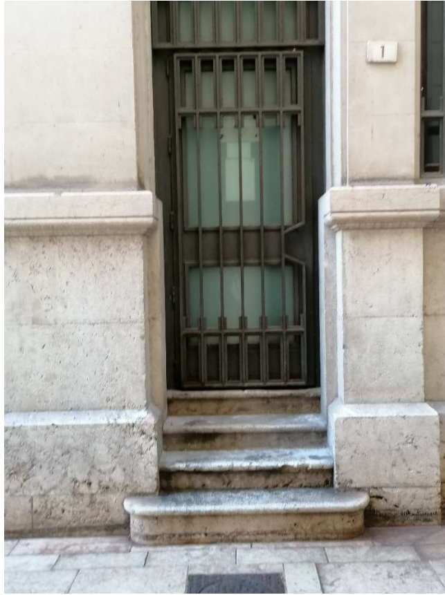
Acceso lateral por la calle Litoral, con escalones originales
