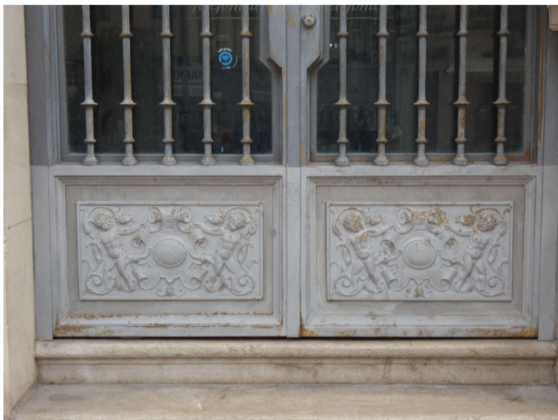
Placas metálicas con relieves neoplatanescos en la puerta principal
