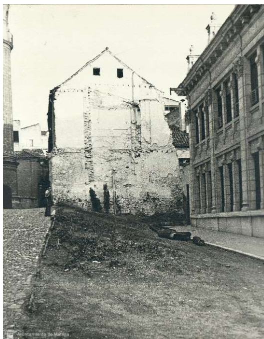
Vista de la fachada a Postigo de los Abades, en la que se aprecia el retranqueo y cambio de rasante. Al fondo a la derecha el solar que se anexó. Archivo Municipal de Málaga
