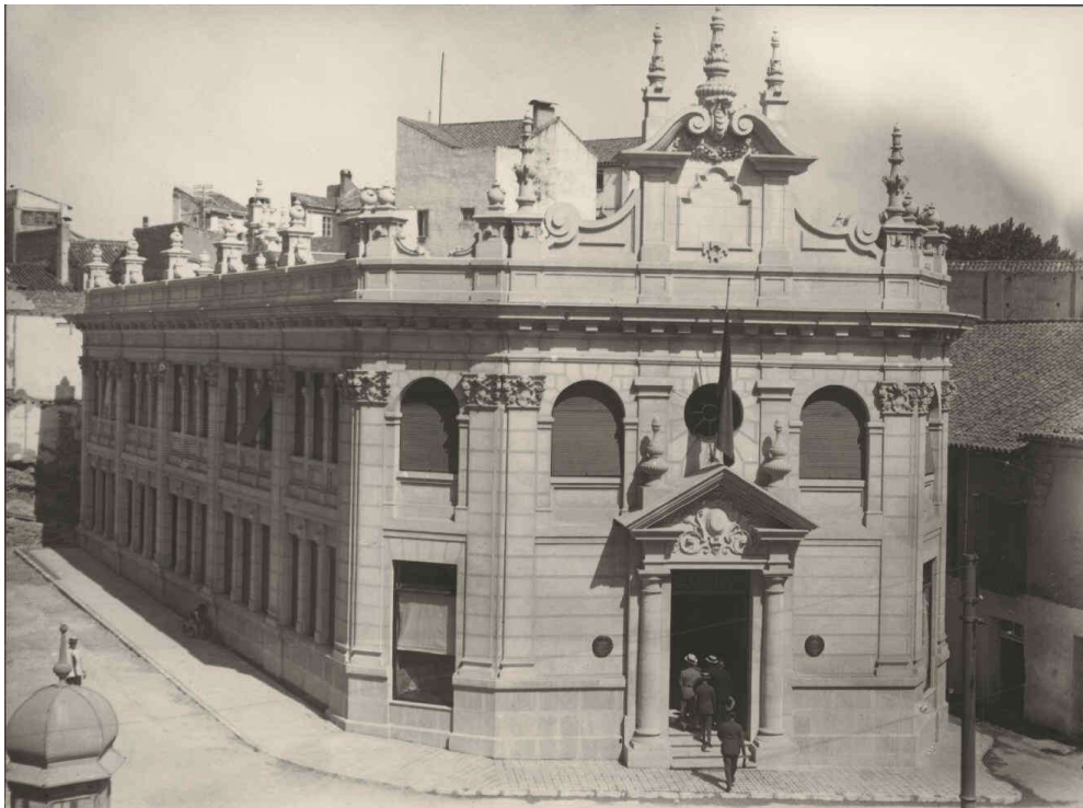
El edificio de la central recién construido. Archivo Fundación Telefónica
