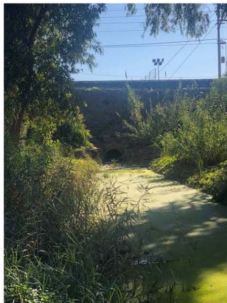
Foto 4. Desagüe del cauce de pluviales del aeropuerto bajo vías de tren.
