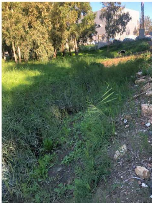
Foto 5. Cauce secundario de pluviales del polígono industrial
