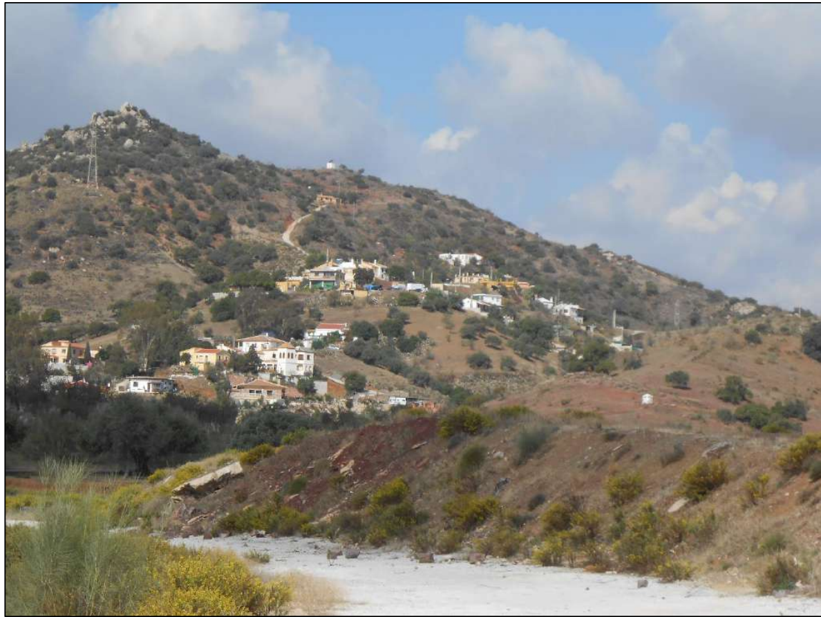
Fotografía de Casas de Lanzas donde se observa la carencia de una mínima estructura urbana, su carácter rural y su desvinculación de cualquier núcleo urbano existente
