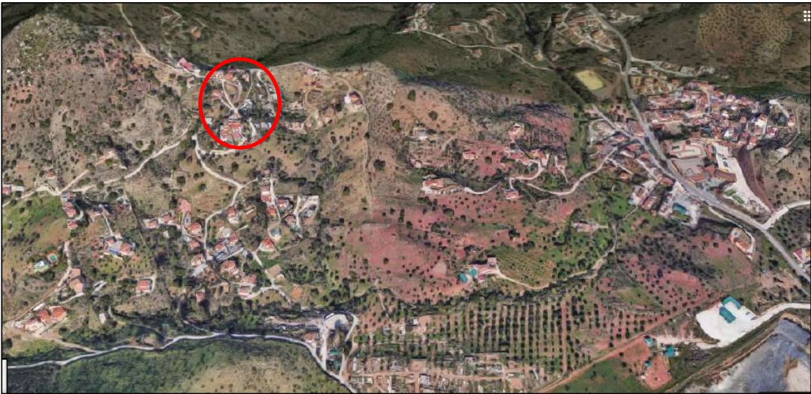
Detalle de la localización de Casas de Lanza según fotografía aérea en 3D
