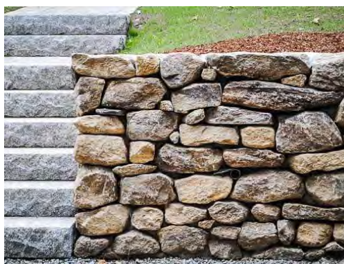
Muro de piedra seca.
