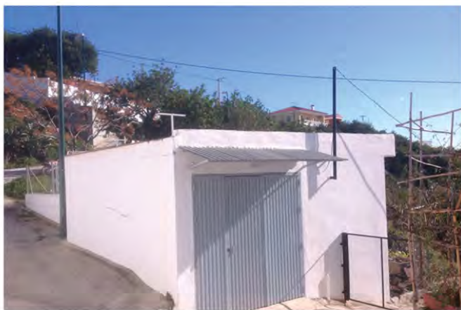
Vista de acceso al equipamiento.
