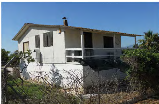
Fachada principal de la vivienda.
