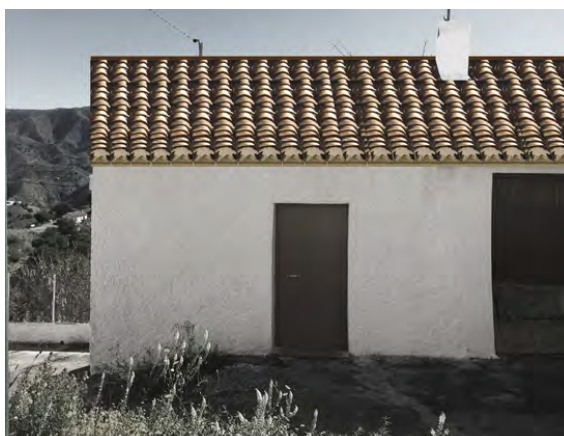
Solución II. Cubierta inclinada de teja
