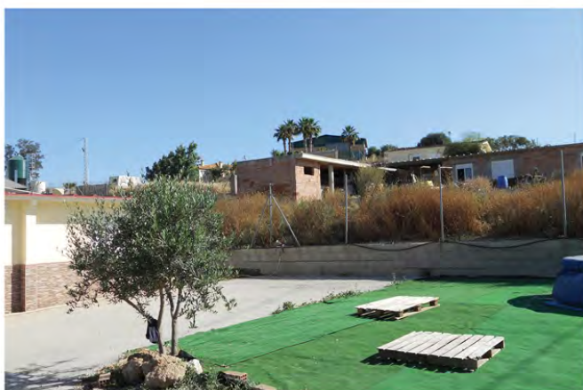
Muro no integrado en el entorno.
