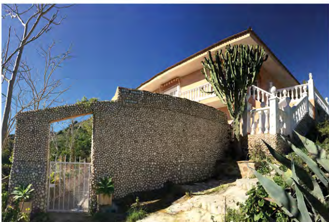
Muro construido de forma artesanal.
