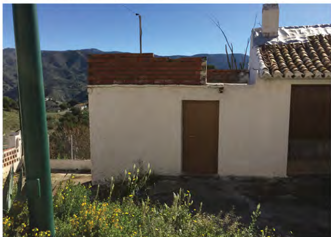
Ampliación de vivienda sin terminar.
