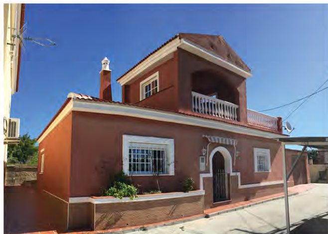
Vivienda de reciente construcción.
