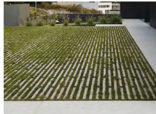
Pavimento mixto en zona de aparcamientos.
