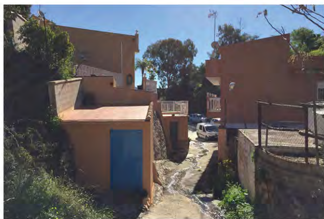
Rambla natural entre dos viviendas.
