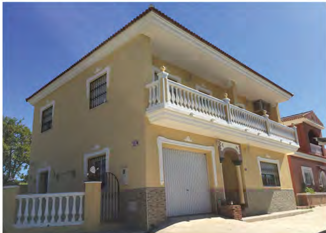
Vivienda de reciente construcción.
