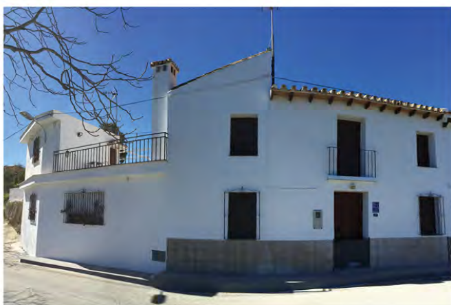
Muro construido de forma artesanal.
