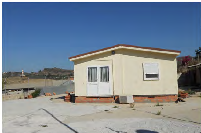
Vista de fachada de vivienda.
