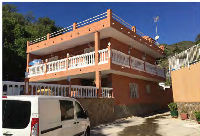
Rambla natural entre dos viviendas.
