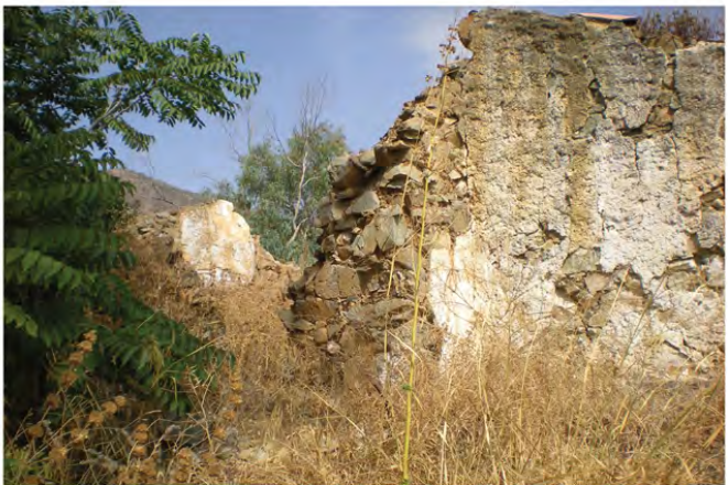
Muros contruidos con piedra del lugar.
