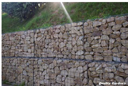
Muro en gaviones de malla soldada.
