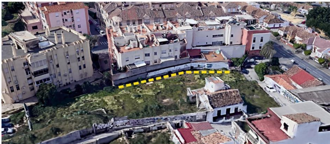
Vista aérea de la medianera de edificaciones colindantes
