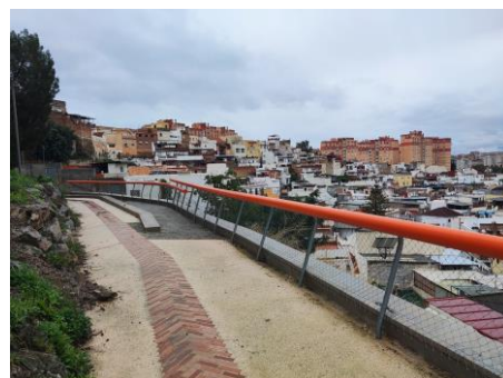
[25] Estado actual del “sendero del Cau”
