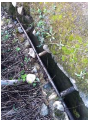
[45] Tramo del Acueducto
