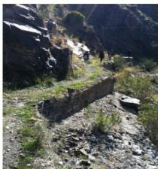
[63] Tramo de acueducto soterrado
