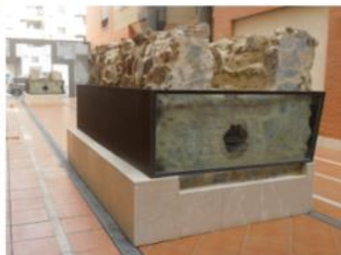
[14] Elemento expuesto del acueducto
