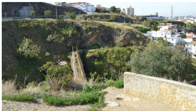
[22] Entorno del Puente de Arroyo Aceitero
