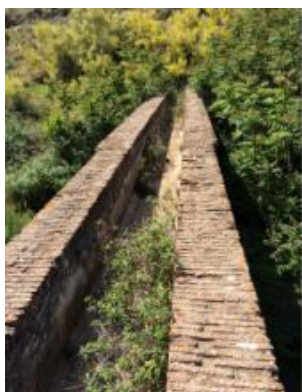
[33] Puente del Aº Leoncillo
