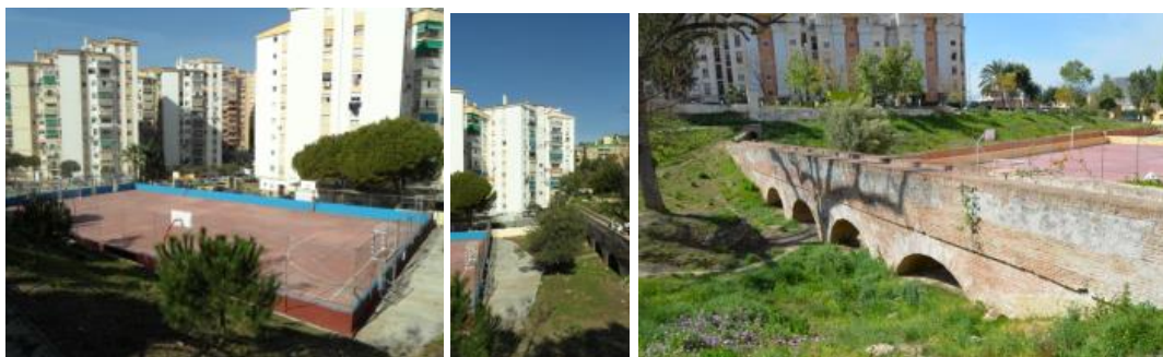
[29] Acueducto de los 5 ojos (enterrado) y pista polideportiva colindante
