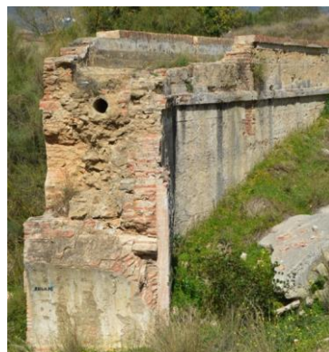
Imagen 12. Detalle actual de una sección del acueducto
