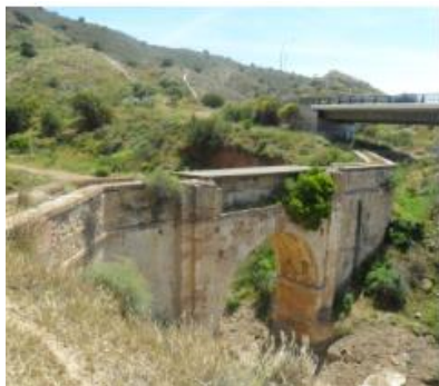
[35] Puente del Aº Sastre
