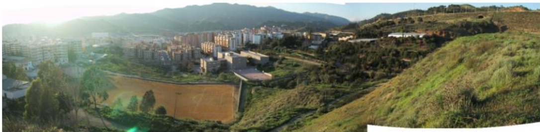
9. Panorámica actual del acueducto Quintana desde el vacío urbano
