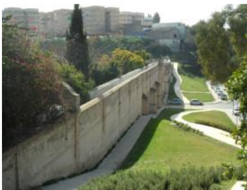
[27] vista del Puente del Aº Quintana rehabilitado.
