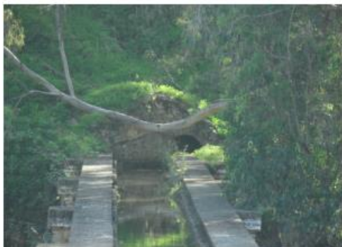
[55] Coronación del Puente del Aº Humaina
