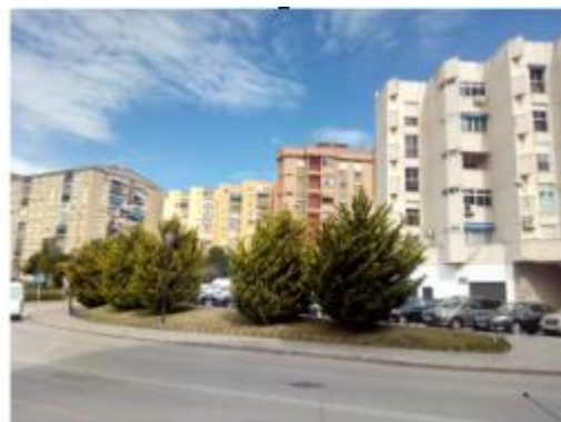
[15] Talud ajardinado de calle Molino de San Telmo
