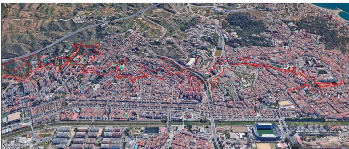
Figura 4. Vista general del entorno del ámbito urbano y las áreas de actuación proyectadas.
