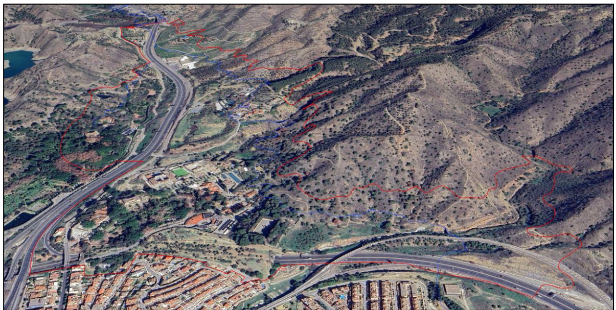
Figura 29. Vista de la UA-2 "Montes de Málaga - La Concepción" (rojo) y del trazado del Acueducto (azul) desde el S.
