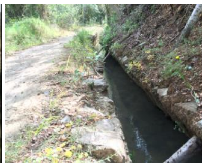
[39] Tramo de acueducto entibado
