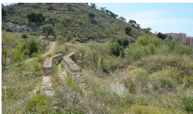
Entorno del puente nº 61. año 2014
