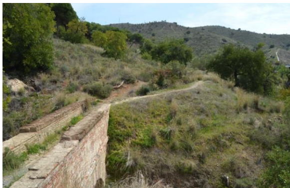
Entorno del puente nº 54. año 2014
