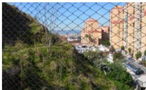
[24] Ladera y Parque del Sur desde el puente
