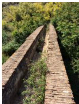
[33] Puente del Aº Leoncillo
