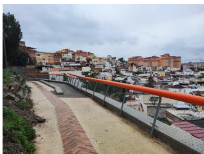
[25] Estado actual del “sendero del Cau”
