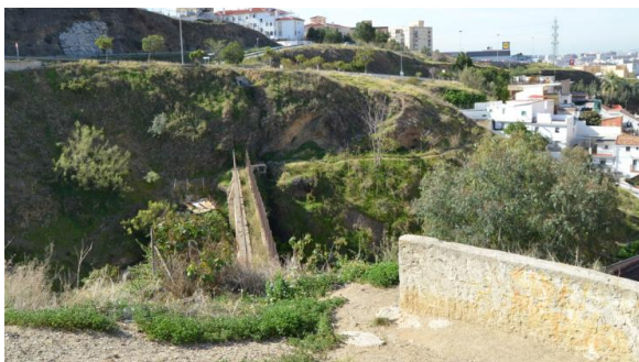
[22] Entorno del Puente de Arroyo Aceitero
