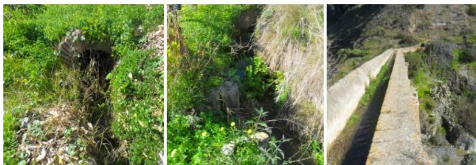
[40] Acueducto y vegetación
