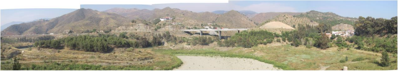
23. Entorno del Pantano del Agujero. Acueducto Humaina bajo viaducto
