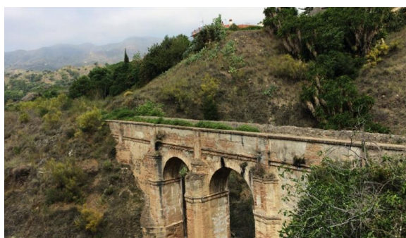
Entorno del Puente nº43 en 2014
