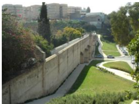
[27] vista del Puente del Aº Quintana rehabilitado.
