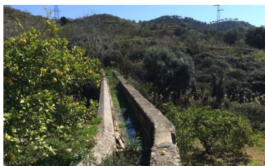
Entorno del Puente nº35 en 2015
