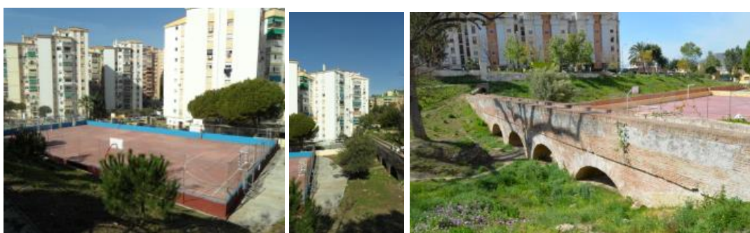
[29] Acueducto de los 5 ojos (enterrado) y pista polideportiva colindante
