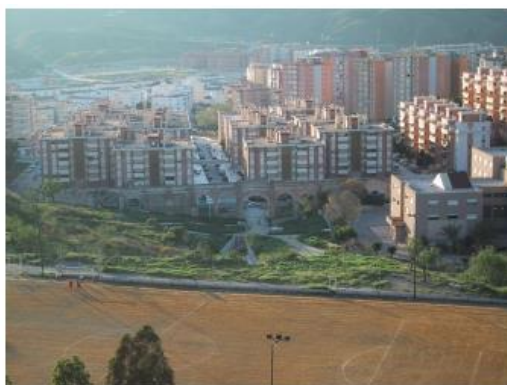
11. Acueducto Quintana y entorno del futuro parque Quintana.
