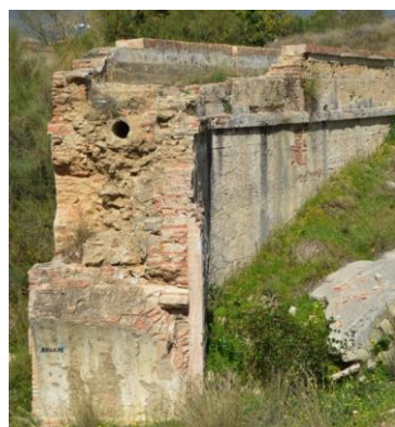
Imagen del detalle actual de una sección del acueducto
