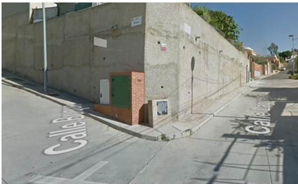
Imagen 6 - Centro de mando de la red de alumbrado público existente.
