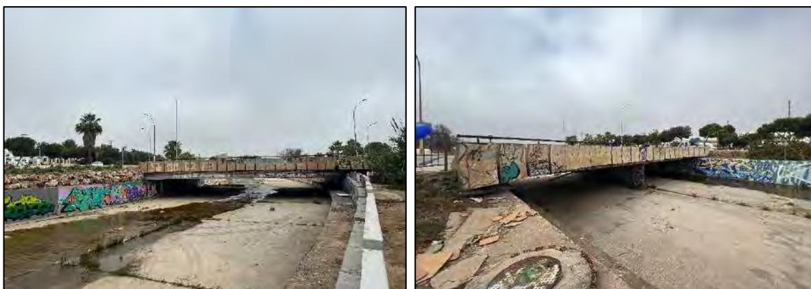
Ambos puentes se han modelizado en el programa InfoWorks ICM© introduciendo la estructura de base lineal 2D. Para el caso particular del puente de la glorieta el cual presenta dos ojos, uno de los ojos se introduce en el programa como *estructura de base lineal* y el otro ojo como *compuerta de estructura lineal 2D*, obteniendo las siguientes estructuras en el mencionado programa.
