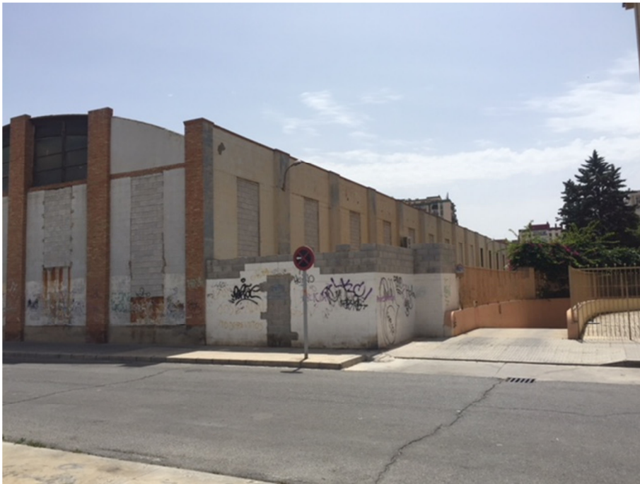
Vista lateral Oeste
