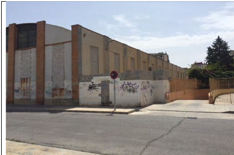
FOTOGRAFÍA 4: Lateral Noroeste, Edificaciones medianeras.
