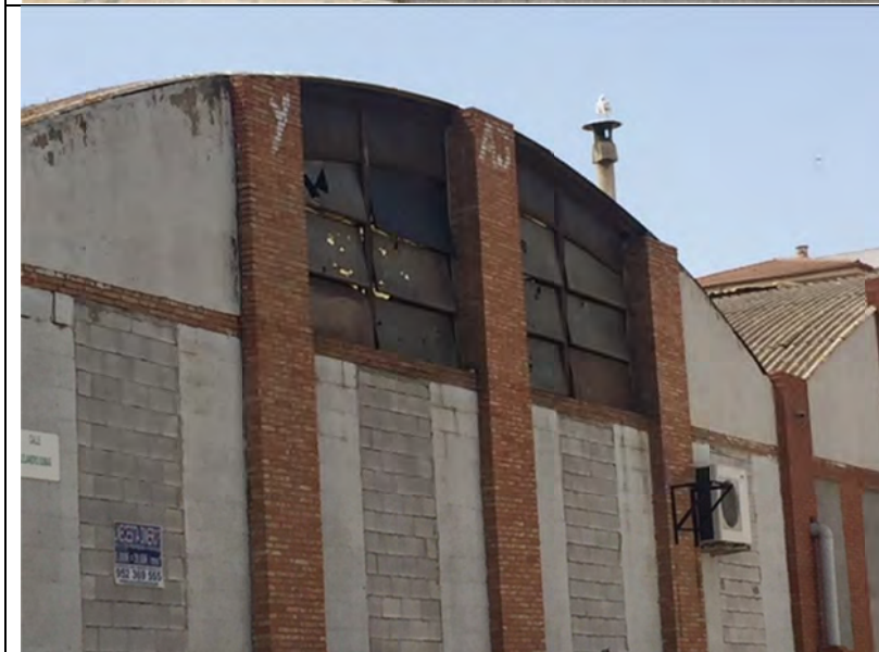
FOTOGRAFÍA 5: Detalle estado edificio
