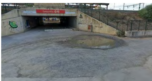
Paso desde Camino Cortijos Campanillas a Estación
