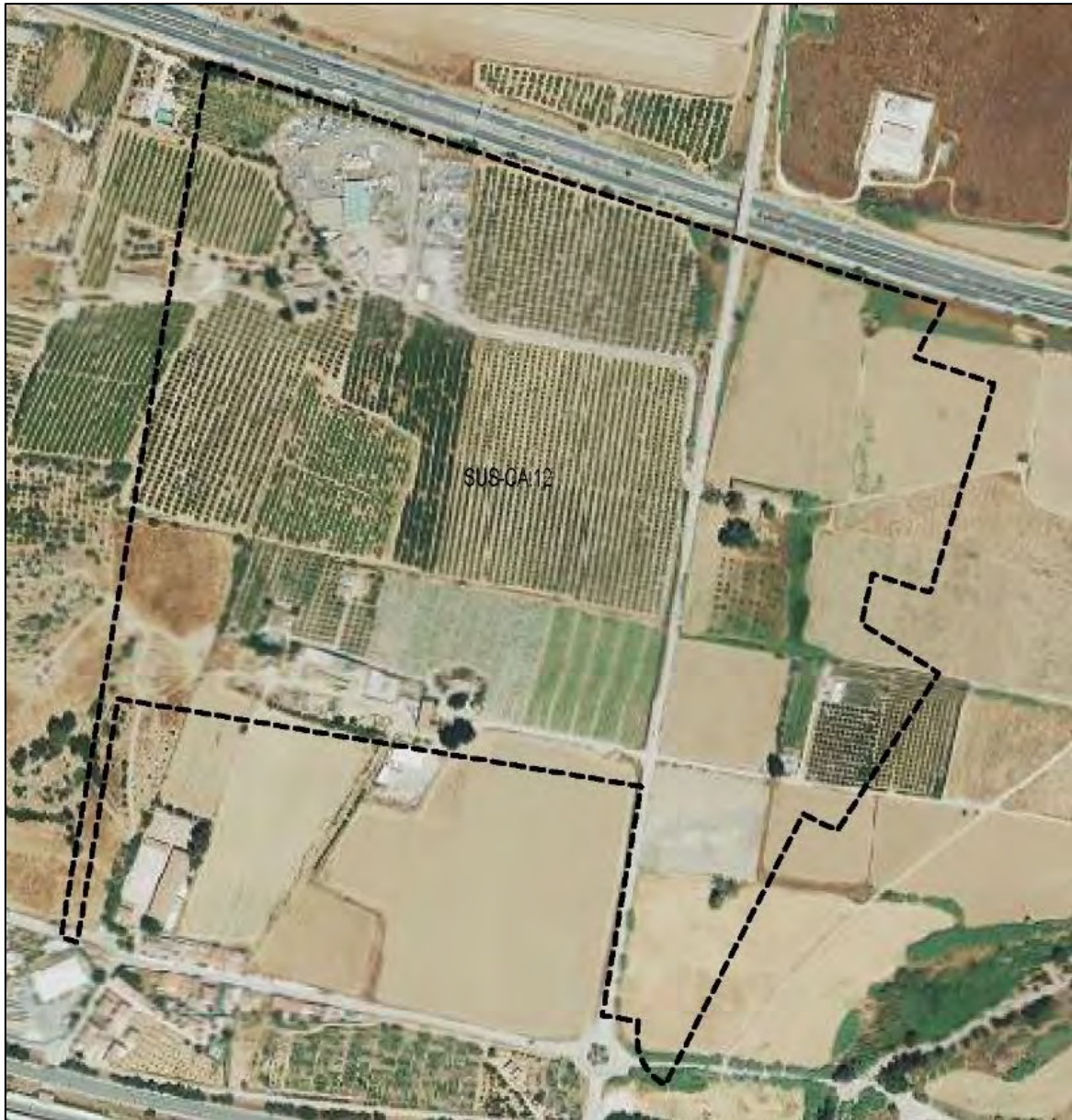
Ilustración 14. Estado actual del sector.
