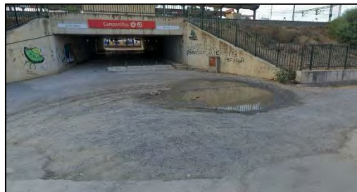
Ilustración 24. Paso desde Camino Cortijos Campanillas a Estación.
