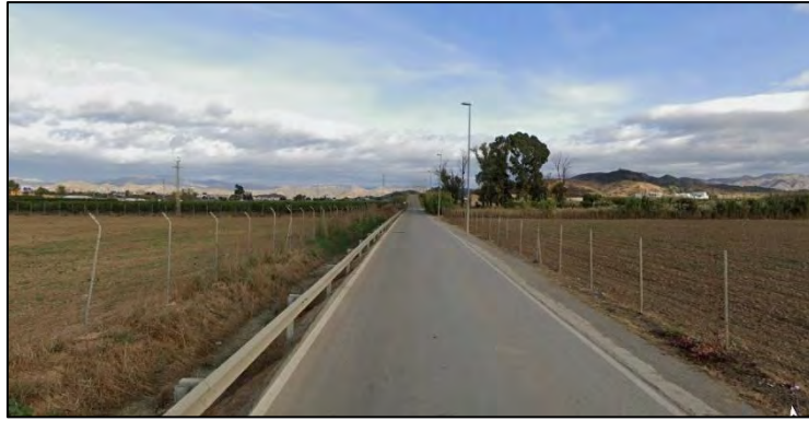
Ilustración 21. A-7055 a su paso por el sector.
