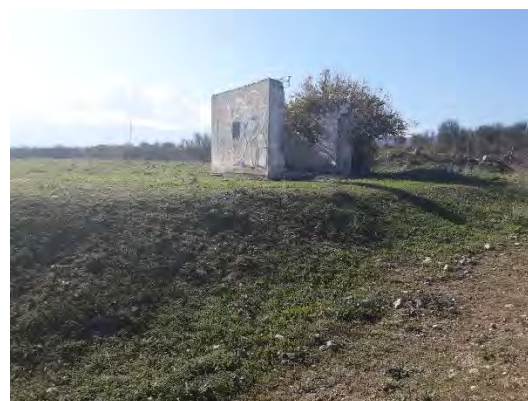
Edificaciones en ruina
