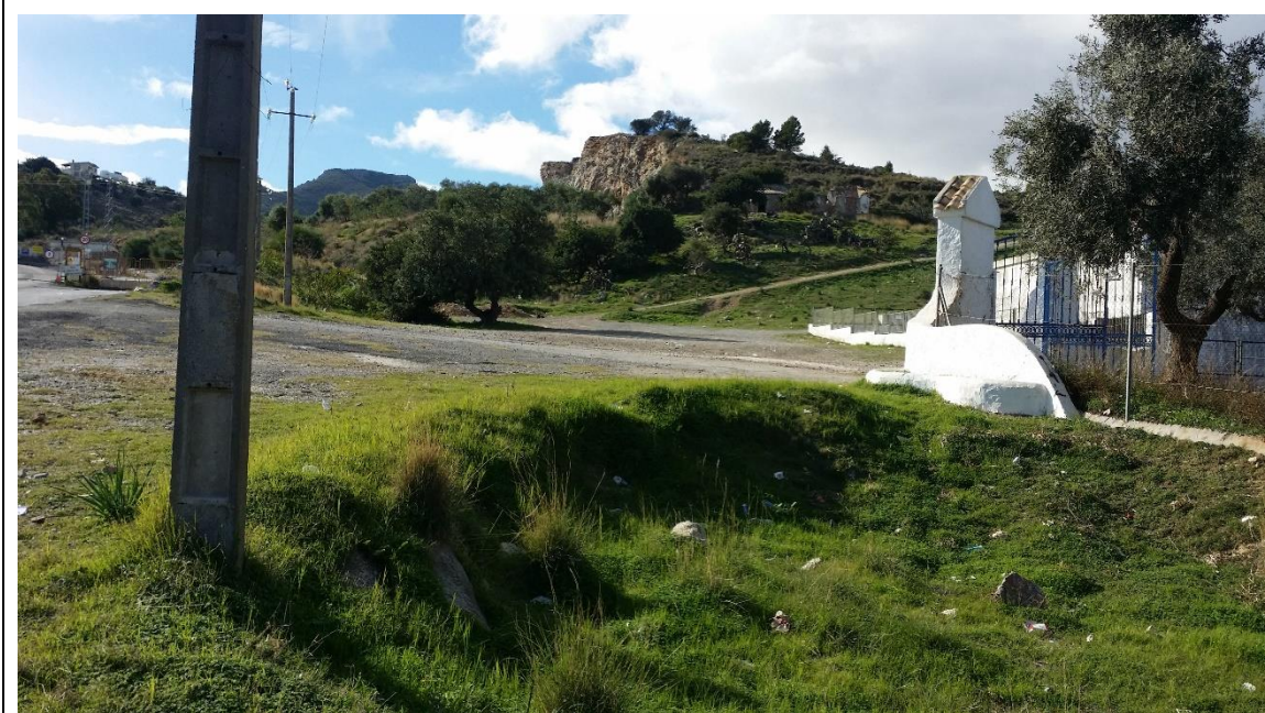
Perspectiva del punto de inicio del estudio Perfil 1000. No se detectan regueros no procedencia del agua cabecera arriba de su cuenca de drenaje. Por la falta de cauce, la misma carretera de acceso a la Cantera actúa de cauce.
