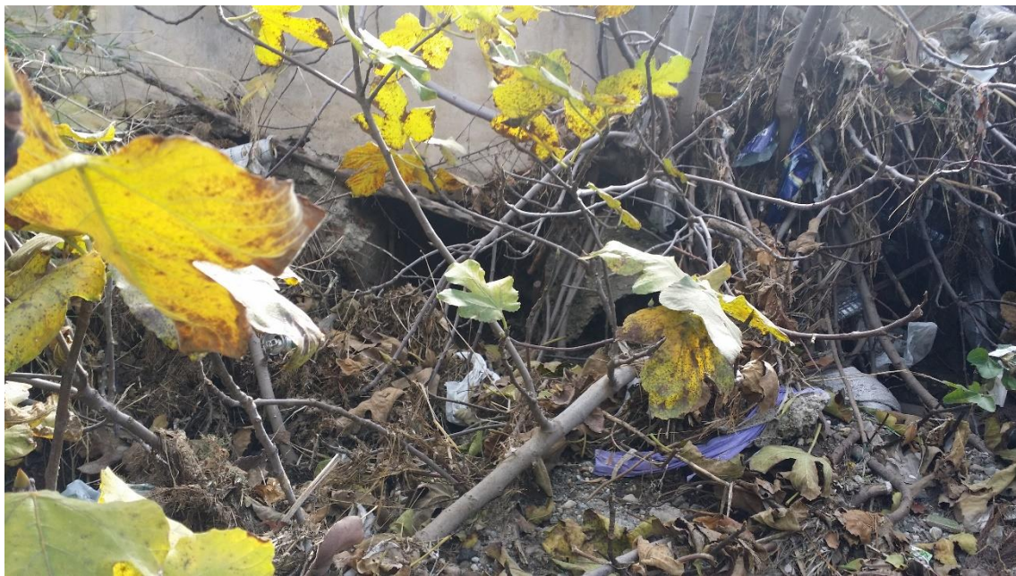
Detalle de la obra de drenaje descrita en las dos fotos anteriores.
