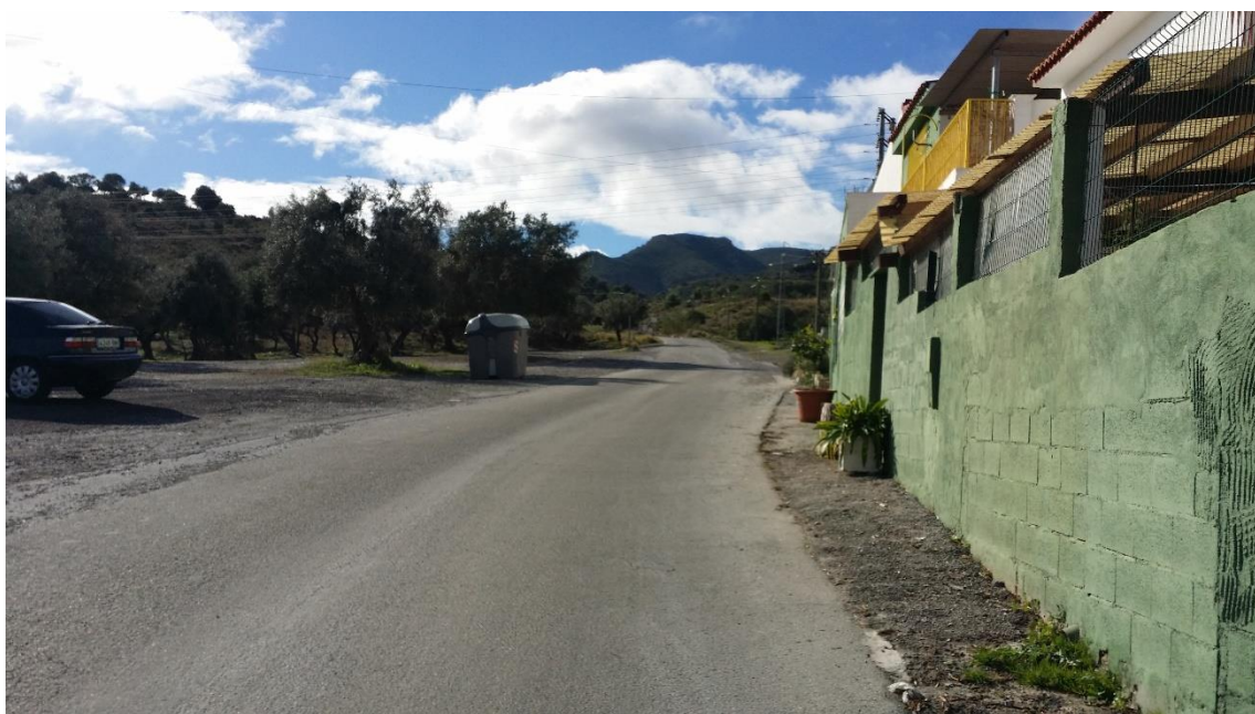
Situación del entorno del cauce limitado por carretera de acceso a la Cantera (izquierda del cauce dirección aguas abajo) y viviendas sobre el antiguo cauce original.
