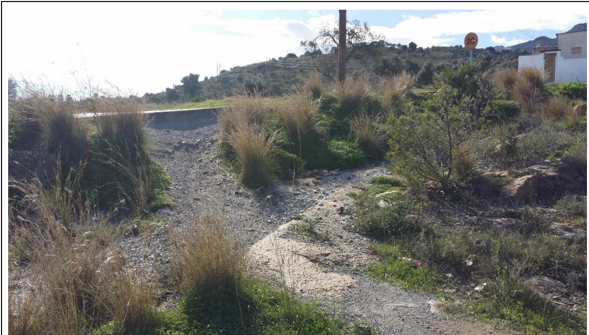
Detalle del estado actual del cauce. Arroyo Cañada de la Calera
