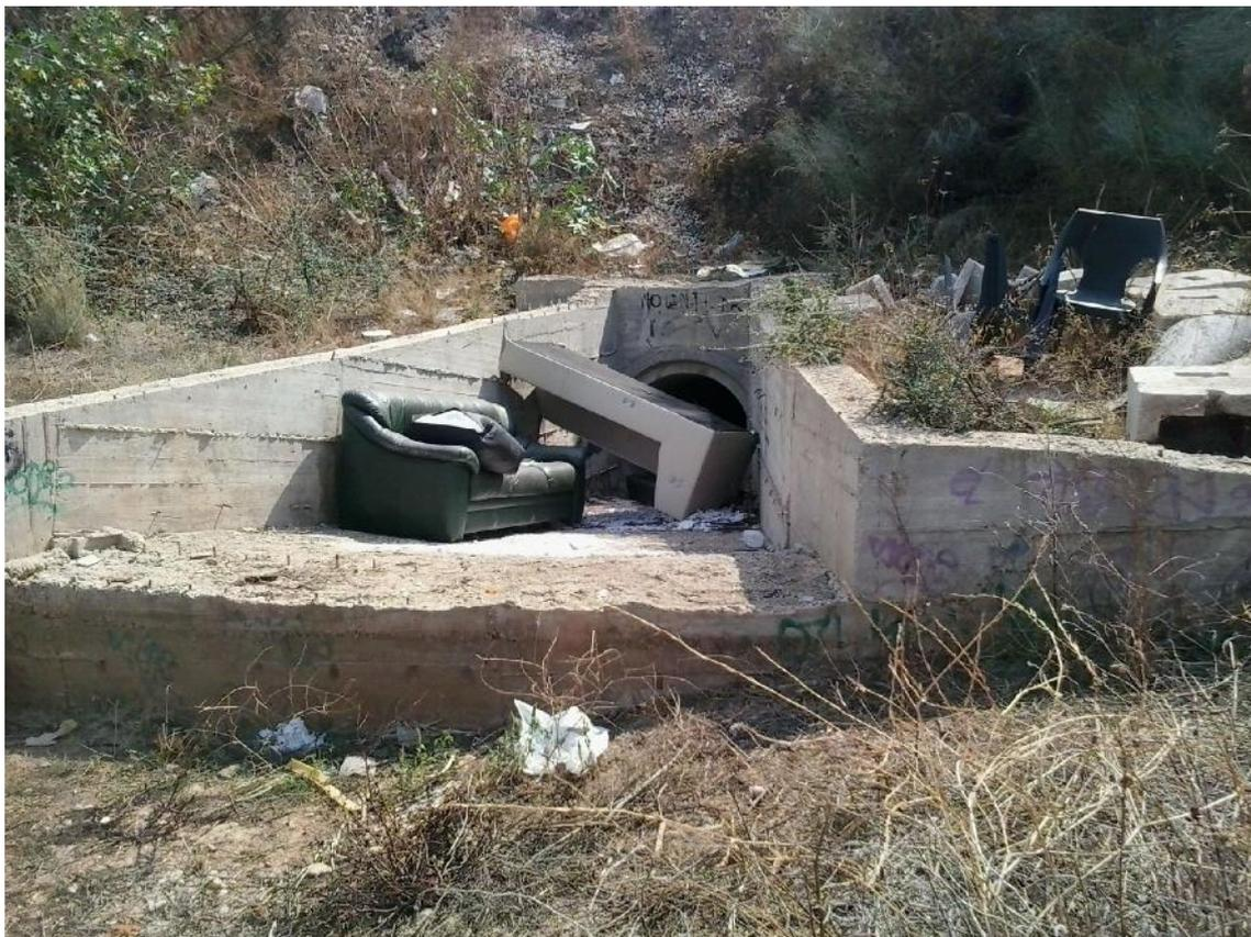
*Imagen N°2: Entrada al tramo soterrado mediante tubería de hormigón de 1.200mm de diámetro.*
