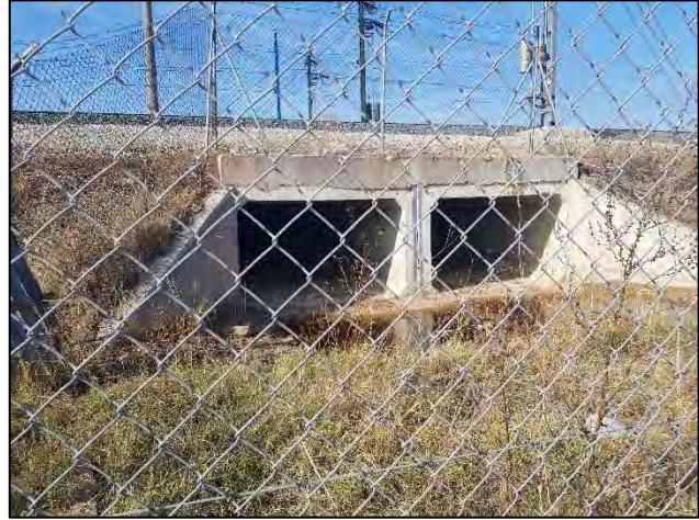
Ilustración 17. Fotografías donde se aprecian dos obras de paso que desaguan directamente sobre el ámbito.
