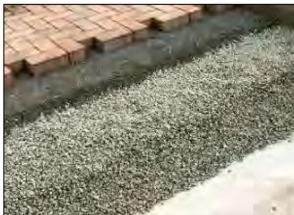
Ilustración 39. *Ejemplo del tipo de asfalto permeable a emplear.*
