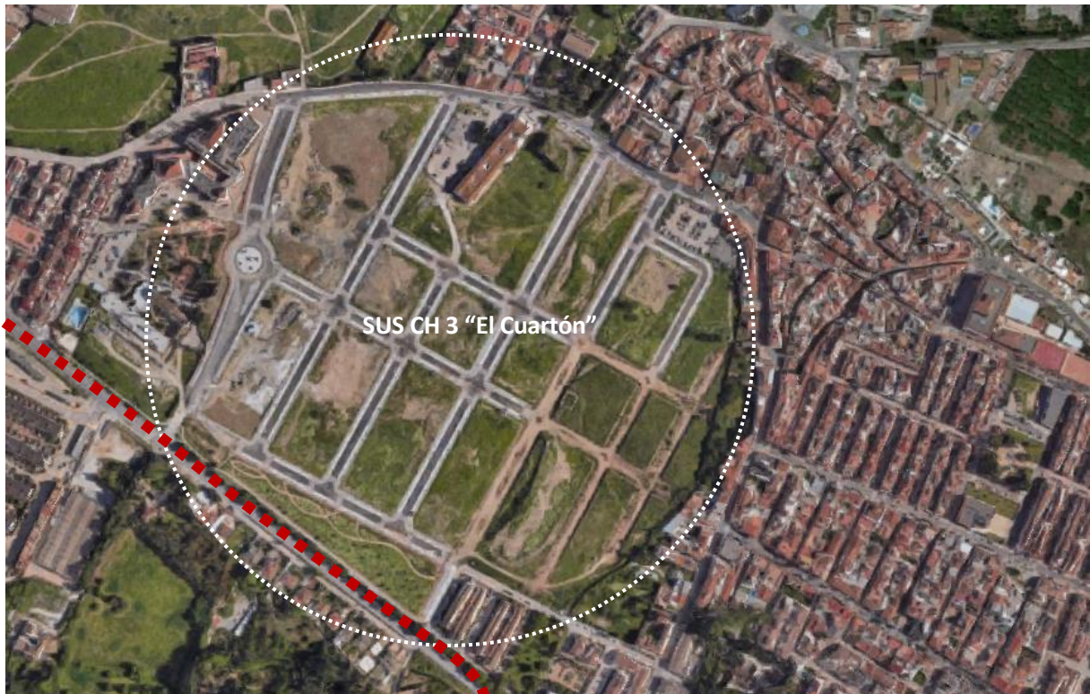
Situación actual de los terrenos en fase de urbanización.
