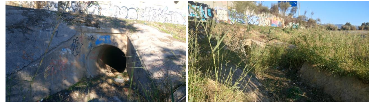
Ilustración 25. Canal de drenaje.
