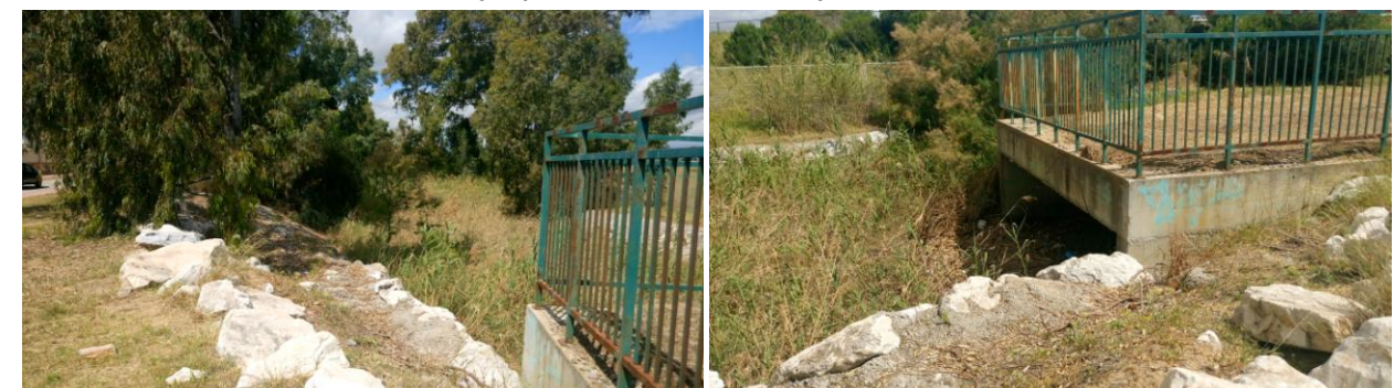
Ilustración 32. Cajón perimetral a Guadalmar bajo la mota del Guadalhorce.
