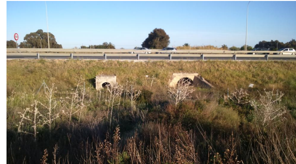
Ilustración 32. Cajón perimetral a Guadalmar bajo la mota del Guadalhorce.
