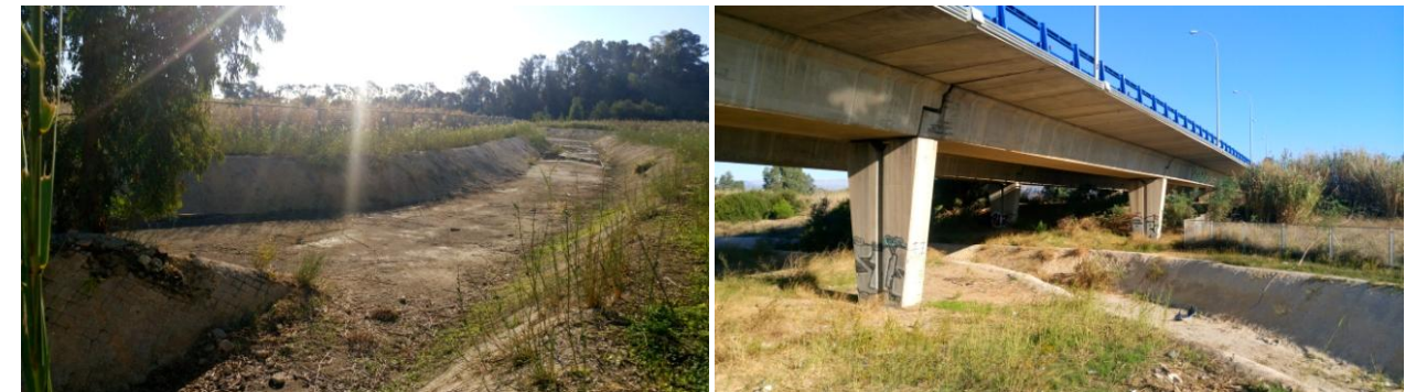
Ilustración 26. Aguas abajo de obra de drenaje bajo rotonda de enlace de MA-20, formada por dos tubos HA \phi 1.000 mm.
