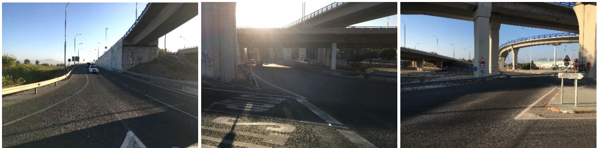
Fotografías 4,5 y 6. Vista a izquierda, frente y derecha desde la isleta de separación del enlace directo a la carretera Guadalmar desde el carril de deceleración de la MA-20 sentido Torremolinos y el carril de entrada a la misma carretera desde la glorieta.
