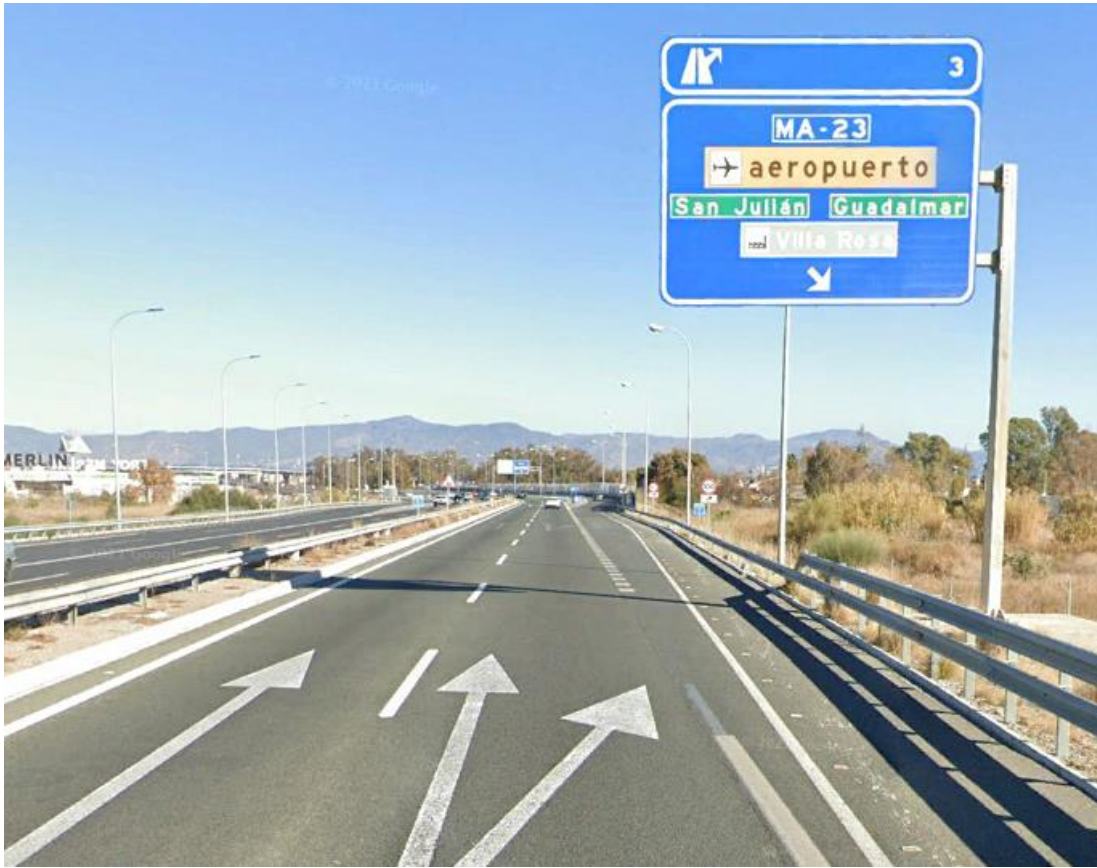
Ilustración 10. Ramal directo de salida 3 de la MA-20 sentido Málaga.
