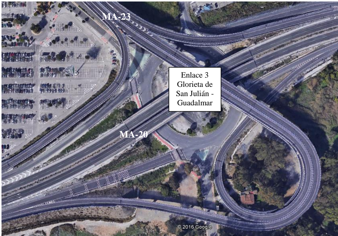
Ilustración 5. Glorieta de San Julián – Guadalmar correspondiente al Enlace 3 de la Autovía MA-20
