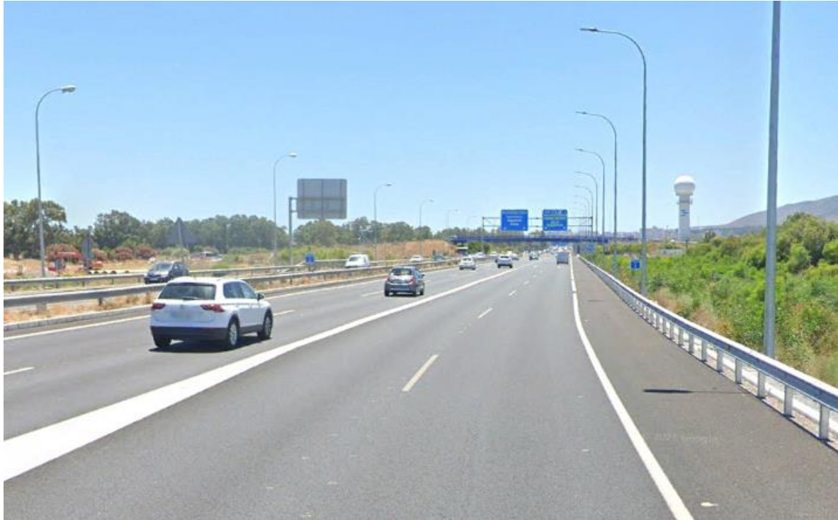
Ilustración 9. Vial de trenzado con dos carriles de circulación para incorporación a la Autovía MA-20 sentido Algeciras
