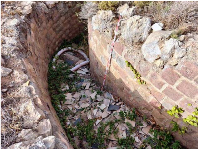
ESCALERA DE ACCESO
