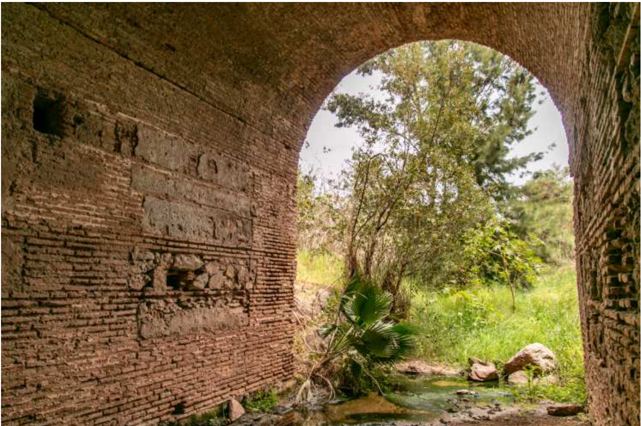
VISTA INTERIOR DEL OJO DEL PUENTE SOBRE EL ARROYO DEL JUDÍO
