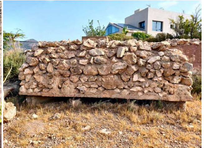
EXTERIOR DEL FRENTE SUR
