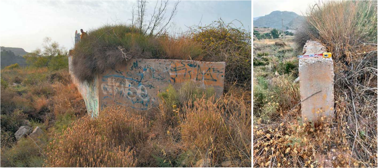
MURO DE HORMIGÓN AL NORTE DE LOS EMPLAZAMIENTOS CAÑONEROS
