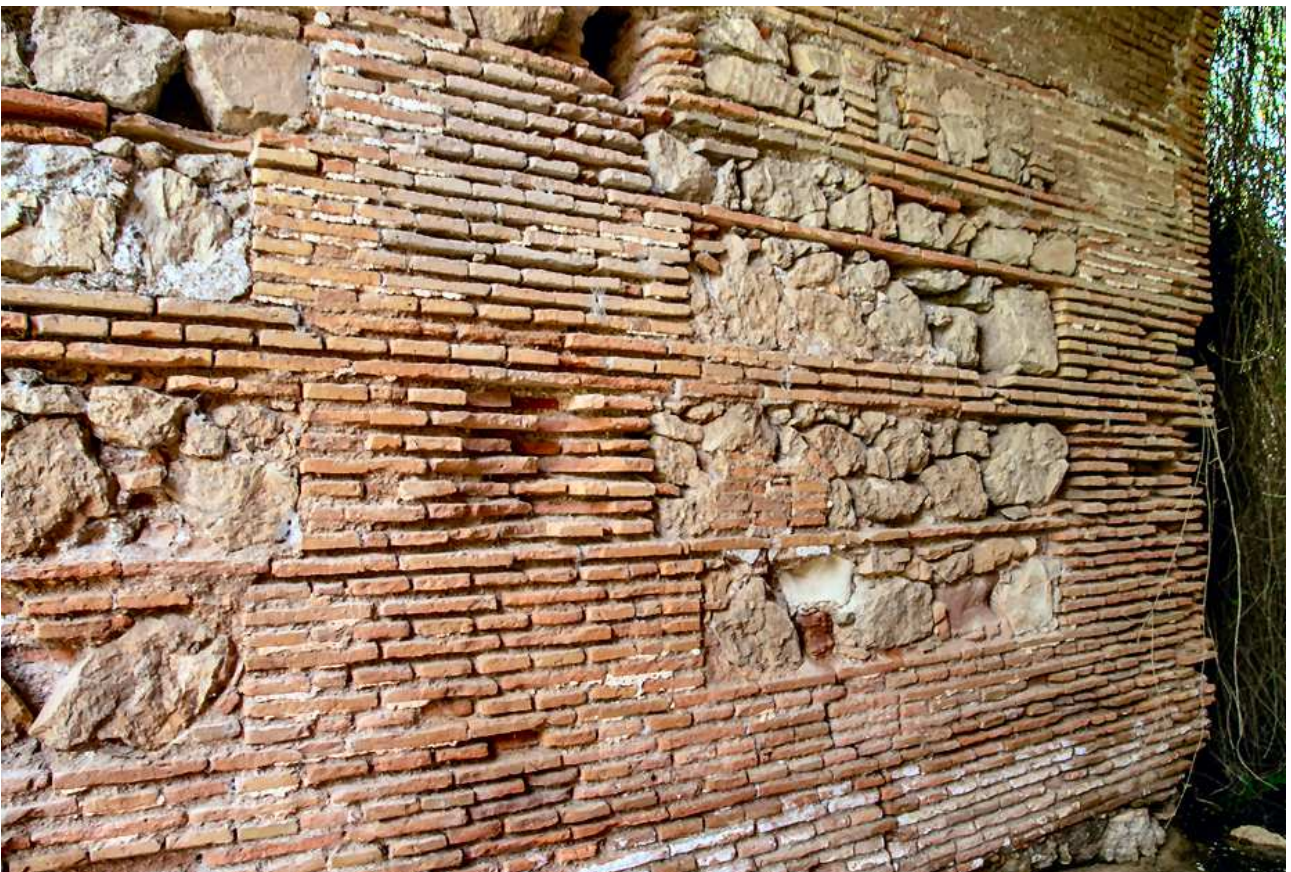
DETALLE DE LA FÁBRICA INTERIOR
