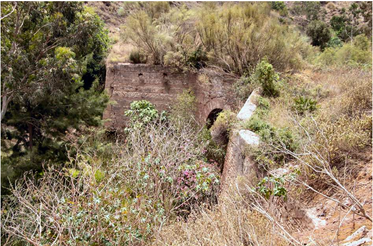
VISTA DEL PUENTE SOBRE EL ARROYO DEL JUDÍO DESDE EL SUR
