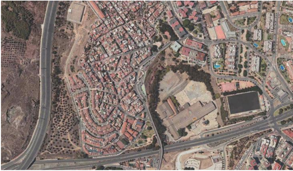
Ilustración 17-ORTOFOTO_ÁMBITO TEJAR DE SALYT_VISTA PLANTA ESTADO ACTUAL
